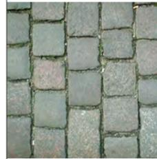
Pavés platine 150x150x150mm existants déplacés et réutilisés pour les trottoirs.
