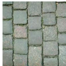
Pavés platine 150x150x150mm pour les zones de raccord de la place sous le auvent.
