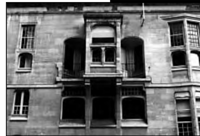
Hôtel Otlet, loggia côté rue de Livourne.
