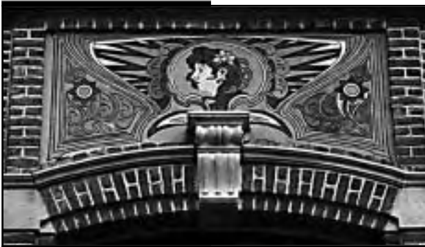
N° 37 : panneau surplombant la fenêtre du première étage.
