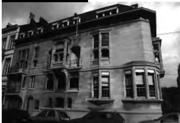
Hôtel Otlet, façade côté rue de Livourne.
