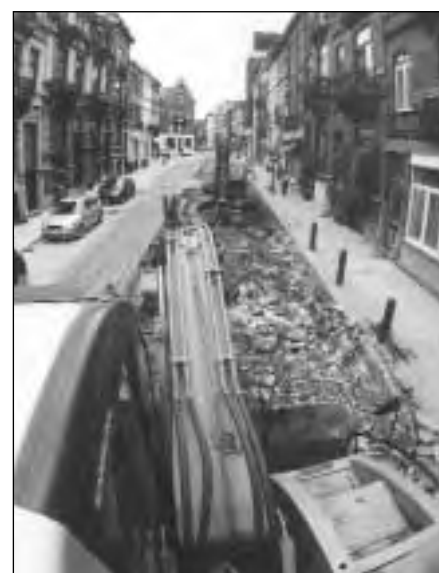
La STIB et la Commune d'Ixelles procèdent actuellement au remplacement des rails de tram ainsi que de la voirie et des trottoirs dans l'avenue de l'Hippodrome. Infos sur le chantier: Service des Travaux: 02 515 63 64. De MIVB en de Gemeente werken samen aan de hernieuwing van de tramrails en van de openbare weg alsook van de voetpaden in de Renbaanlaan. Info: tel. 02 515 63 64.
