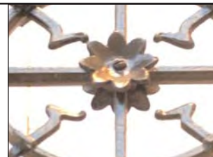
Detail van de balustrade
